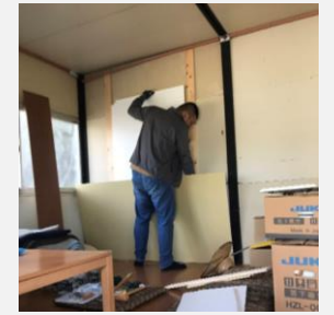
山小屋の改修工事。フローリングも張りました
